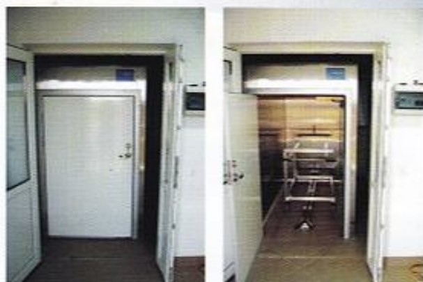
KOMORA CHŁODNICZA W SYSTEMIE WÓZKOWYM NA 2 TRUMNY
